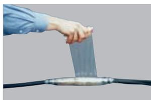
Компаунд сдвигается путем обмотки сростка эластичной виниловой лентой
