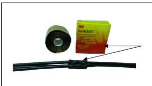
Для изоляции опрессованных медных луженых гильз, необходимо использовать электроизоляционную мастику Scotchfil, с помощью которой создается крестовина. Это необходимо для предотвращения замыкания проводов между собой. Применение электроизоляционной мастики Scotchfil на этом этапе не обязательно, достаточно развести опрессованные гильзы для предотвращения их замыкания между собой.
