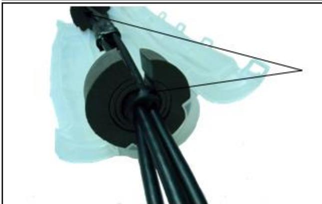
Для того чтобы предотвратить вытекание компаунда во время заливки, необходимо создать уплотняющий бандаж из электроизоляционной мастики Scotchfil с обеих сторон муфты, как показано на рисунке
