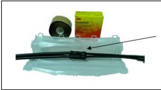
Соединенные провода укладываются в корпус муфты.
